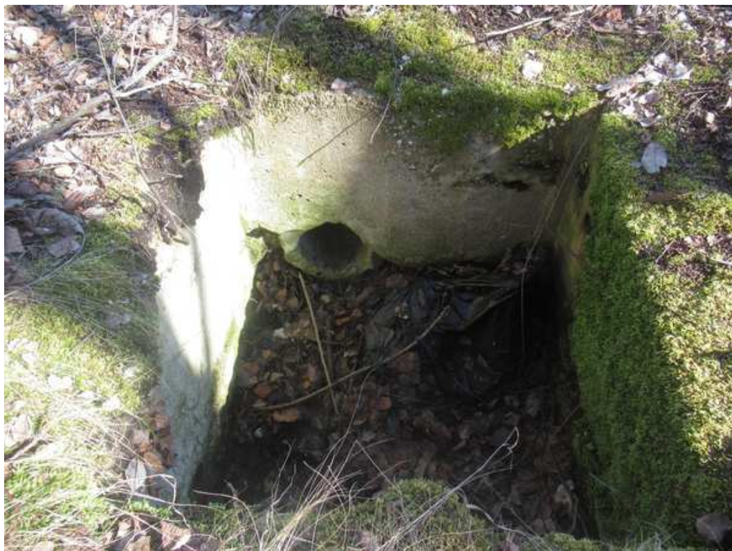
Obr. č. 9 - pohled na pravděpodobně odvodní betonovou rouru k SV v šachtě Š4
